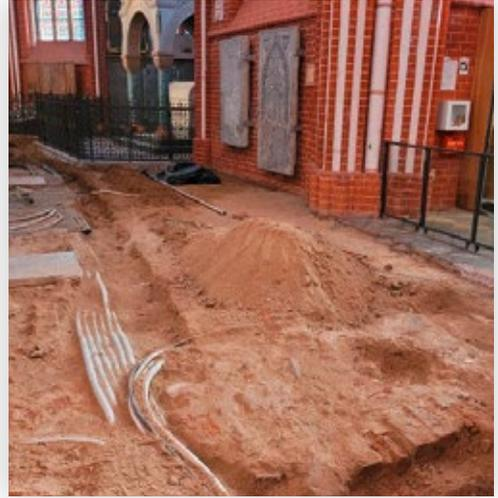
Im südlichen und östlichen Chorumgang werden derzeit im Kontext der Fußbodensanierung marode Kabel ersetzt und Leerrohre verlegt. Letztere ermöglichen bei späteren technischen Veränderungen Nachrüstungen, ohne den Fußboden erneut öffnen zu müssen.
